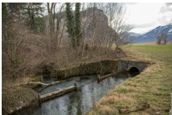
Einleitung von Rheingrundwasser zur Wiederbewässerung des Naturschutzgebiets Äulehäg in Balzers, 2018 (Foto: Rainer Kühnis, Vaduz). Das eingeleitete Wasser wird unterhalb der Rheinsohle gefasst. Es ist immer klar und
