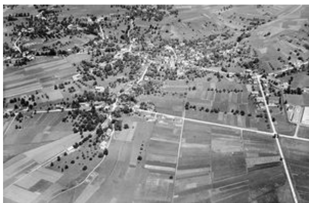
Luftbildaufnahme von Eschen, 1946 (LI LA). Foto: Foto Gross, St. Gallen.
