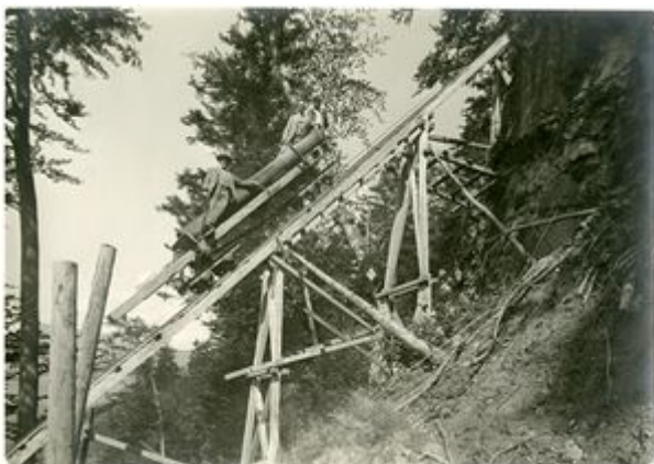
Bau des Lawenawerks, links Bauunternehmer Franz Joseph Beck, Chur, in der Mitte Ingenieur J. Weber, Zürich, 1926 (Liechtensteinisches Landesarchiv, B 521/009/003, Foto: Landesarchiv / Fr. Schmelhaus, Zürich).
