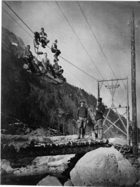
Holzarbeiter auf der Seilbahn und auf dem Holzsteg über den Saminabach beim letzten grossen Holzschlag im Garselliwald, ca. 1927 (Liechtensteinisches Landesarchiv, SgAV 18/4/073, Foto: Friedrich Reich, Triesen).
