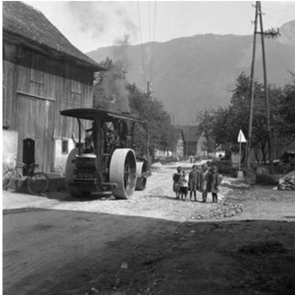
Die «Landesdampfwalze» im Einsatz bei der Strassenteerung im Weiherring in Mauren, erste Hälfte 1930er Jahre (Tschugmell-Fotoarchiv, Gemeindearchiv Mauren, Foto: Fridolin Tschugmell).
