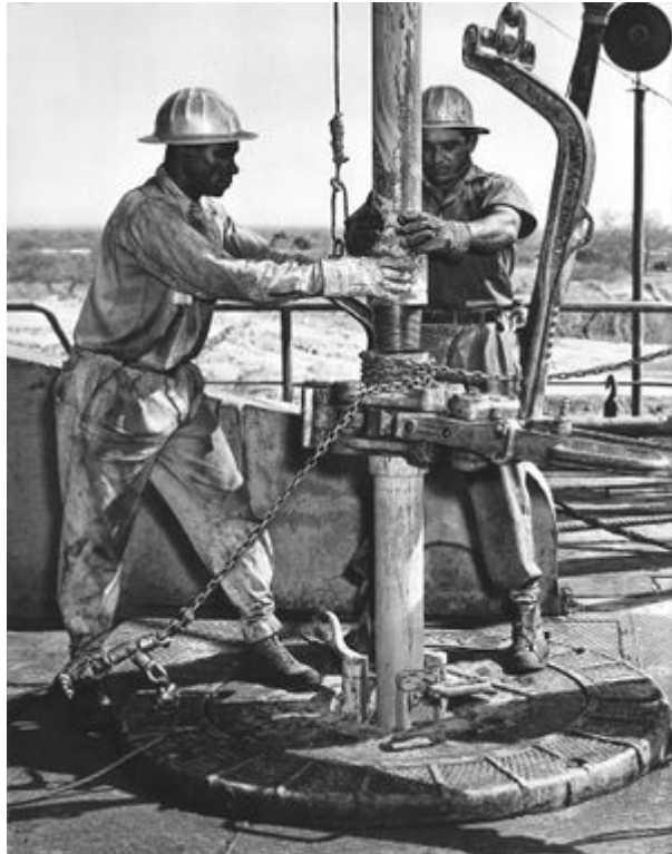
Shell-Mitarbeiter in Venezuela beim Einsetzen eines neuen Bohrrohrs, 1950er Jahre. Foto von Walter Wachter in seinem Buch «Land der Gegensätze Venezuela» (© Büchergilde Gutenberg, Zürich 1960).
